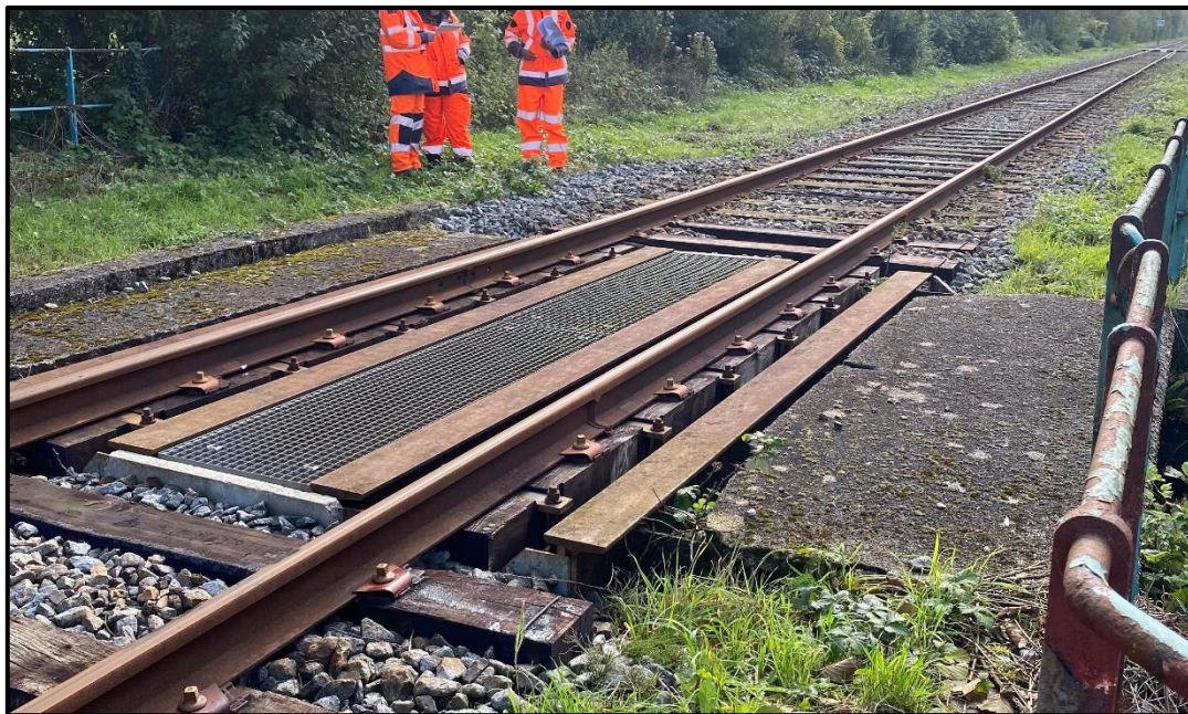
Figure 2 : Ligne 325 000 - Vue du dessus de l'ouvrage au Pk 138+046
