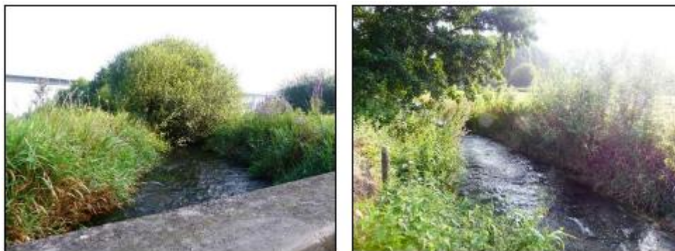
Figure 22 : Ligne 325 000 - Vue aval du cours d'eau
